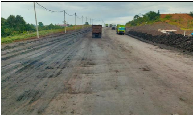
Gambar 4 Kondisi Jalan Menuju Dump Hopper
