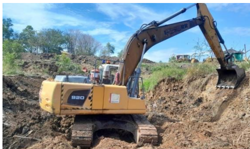
Gambar 7 Persiapan awal pembuatan slope
