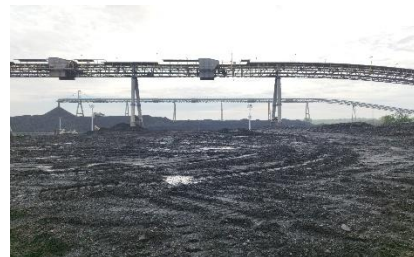
Gambar 16 Area Tidak Stabil Sumber: Dokumentasi Pribadi
