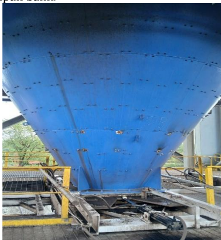
Gambar 3 Weigh Bin di TLS 102
