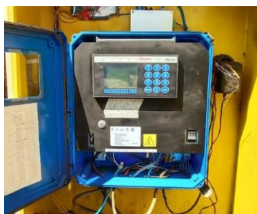
Gambar 5. Integrator Pada CC.10 TAL
