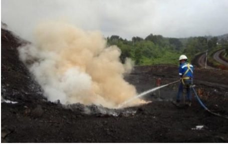
Gambar 2. Tahap Penyemprotan Batubara menggunakan Larutan Kimia
